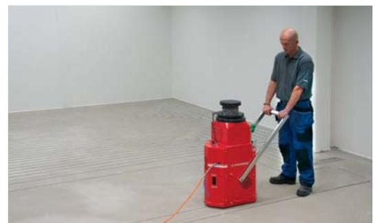
DAIKIN cut: Die Kanäle zur Verlegung der Heizrohre werden in den vorhandenen Estrich eingefräst.
